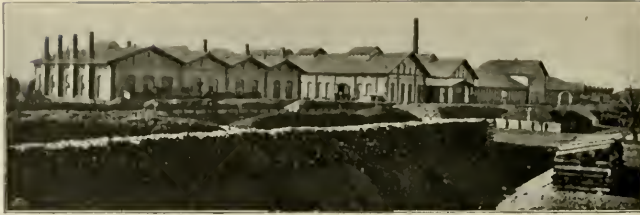
Abb. 377. Werkstättenanlage Nen-Sandec der k. k. Oesterreichischen Staatsbahnen.
